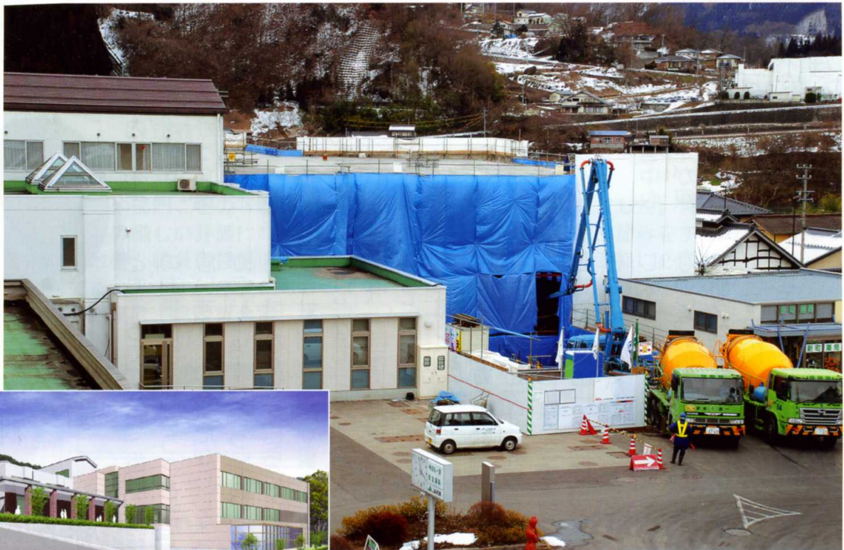
診療棟病棟建設工事の様子(上)と完成予想図(左)
